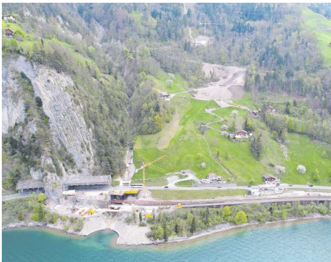
Über den gesamten Hang verteilt sind Schutzbauten angebracht.
